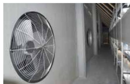
**I sistemi di essiccazione Dorset** sono stati riconosciuti dal governo Olandese (E.6.4.2) come impianti per la riduzione delle emissioni di ammoniaca degli allevamenti. Anche le polveri più sottili vengono filtrate grazie a delle speciali tecnologie. La riduzione delle polveri è del 70%, in relazione all'intero allevamento del 50%.
